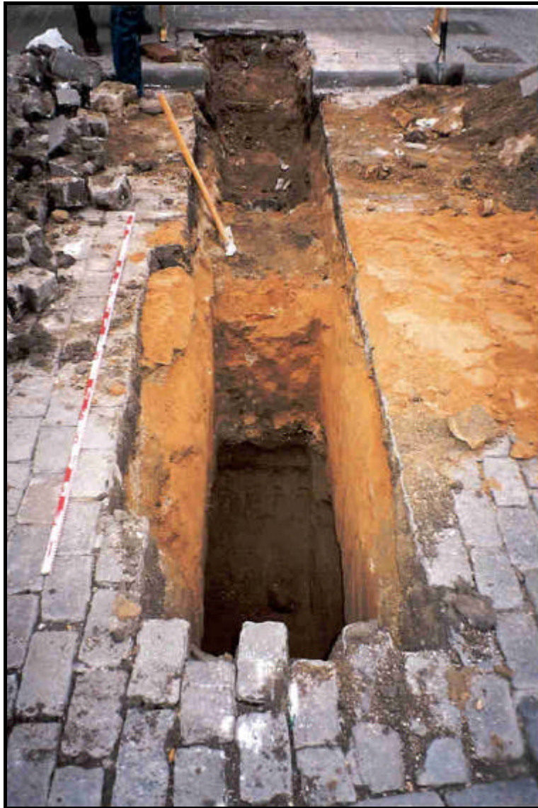
F. 2: Vista general de la Rasa 2, amb el col·lector al centre.
