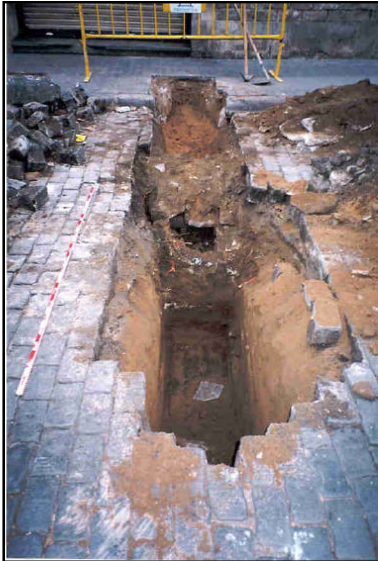
F. 1: Vista general de la Rasa 1, amb el col·lector al centre.
