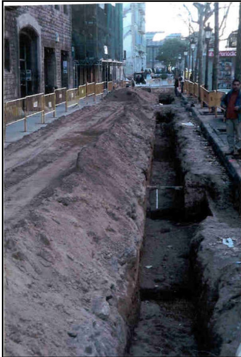
F. 12: Vista general del tram de la Rasa 4, on apareix una estraigrafia d'època romana.
