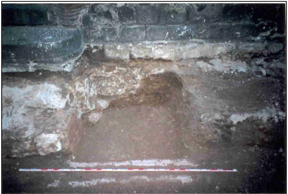
F. 22: Detall de l'angle de la paret i el Sondage 7.
