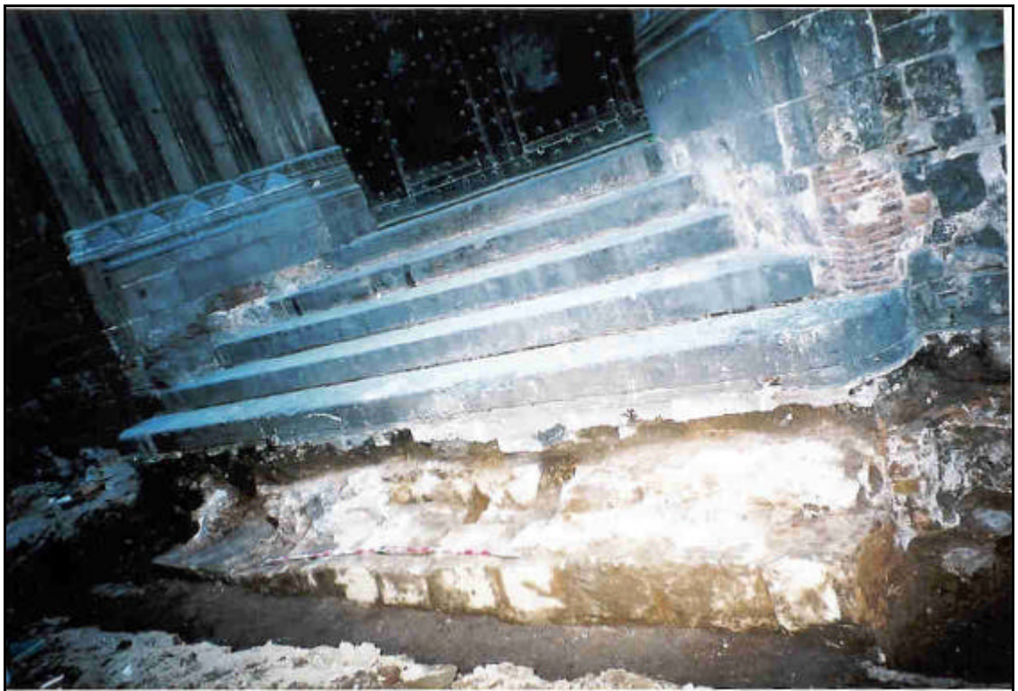
F. 20: Vista general de la paret (u.e.: 305) al C/ Sombrerers.
